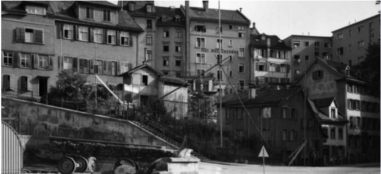
Die inessiven Hangbauten Lämmlibrunnenstr. 36 u. 36a, 9000 St. Gallen (1956)
