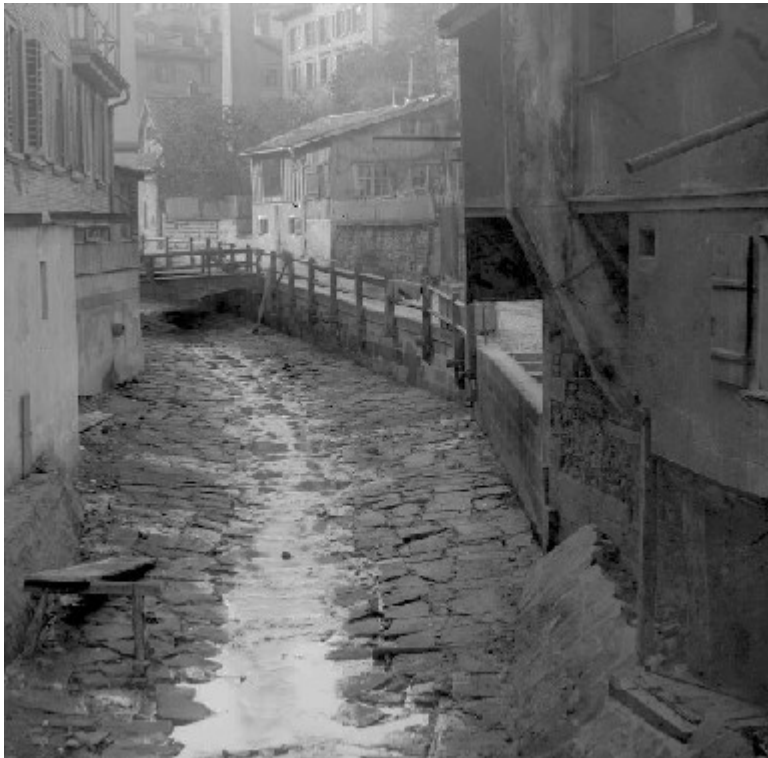
Lämmlisbrunnenstr. 18 (rechts) u. Linsebühlstr. 19 u. 17 (links), 9000 St. Gallen (1890)
