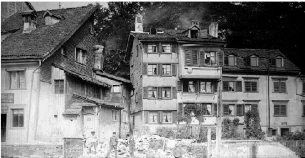
Lämmli-brunnenstr. 39 (links; dahinter Nr. 39a) und 39b-c (rechts), 9000 St. Gallen (1891)
