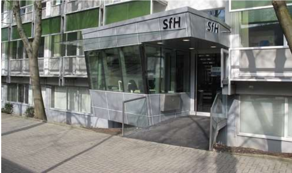
Pförtnerloge, Dortmund (Photo: Matthias Berke, Wien)
